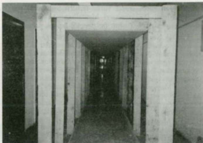
Az összekötő részben is folyó munkák miatt a kórházi egységek közötti közlekedést egy a földszinti folyosón belül kialakított átjáróval biztosították a kivitelező cég szakemberei
