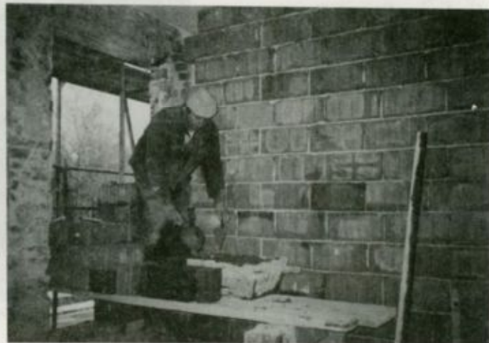
Jó ütemben halad a munka a "B2" épületszárnyban
