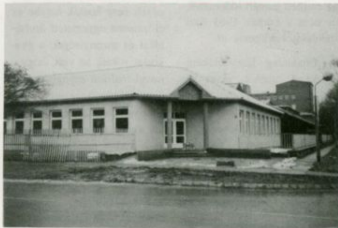
Átadás előtt az új épület. Már csak a belső szerelési munkálatok utolsó része, a gépek beépítése és beüzemelése van hátra. Az épület hamarosan fogadhatja a szűrésre jelentkezőket és a betegeket.
