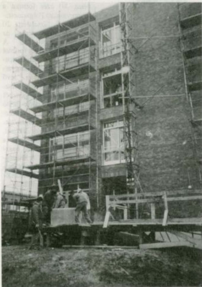
A "B2" szárny átalakítása során keletkező törmeléket az épületrész nyugati végén, a betegellátást végző részeketől a lehető legmesszebb található helyen juttatják a szabadba a Kelet-Speck Kft. munkatársai, és innen történik az építőanyagok bejuttatása is az épületbe
