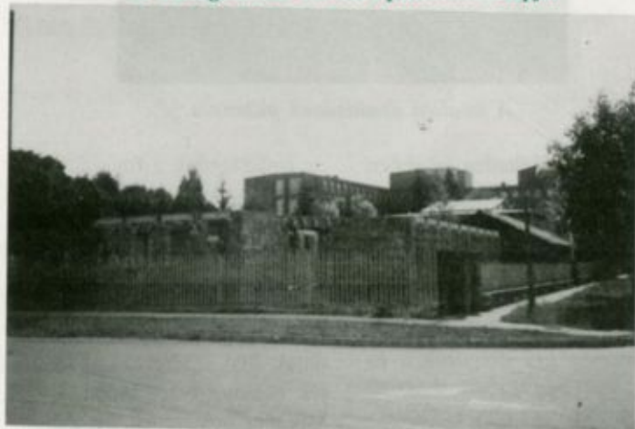
Az építkezés képen látható fázisában már álltak a falak, és a kivitelező cég szakemberei a tető megépítését készítették elő.
