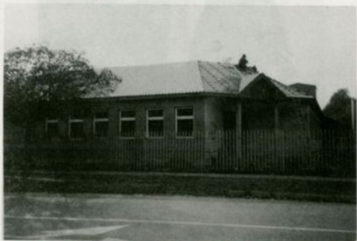
Helyükre kerültek a nyílászárók, a tetőfedő anyag nagy része, és megtörtént a falak vakolása is.
