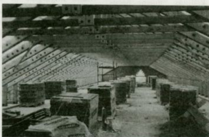
A cserepek felhelyezése előtti állapot az összekötő rész tetejéről fényképezve
