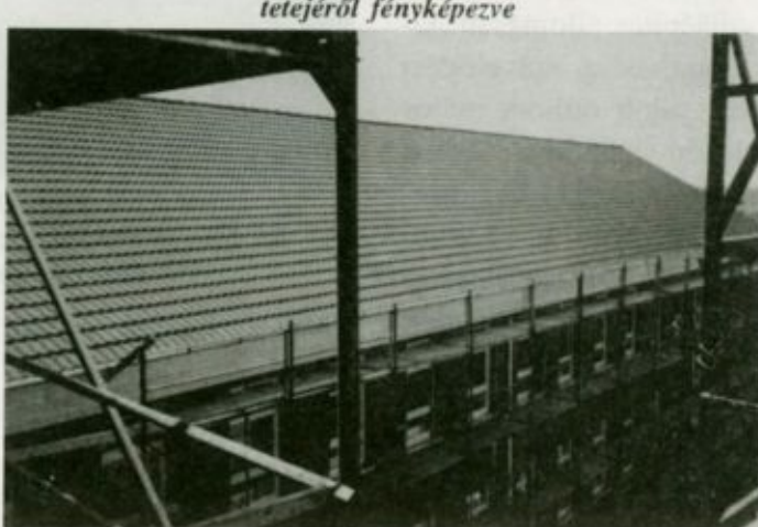
Az elkészült, új tető a "B2" épületrészen
