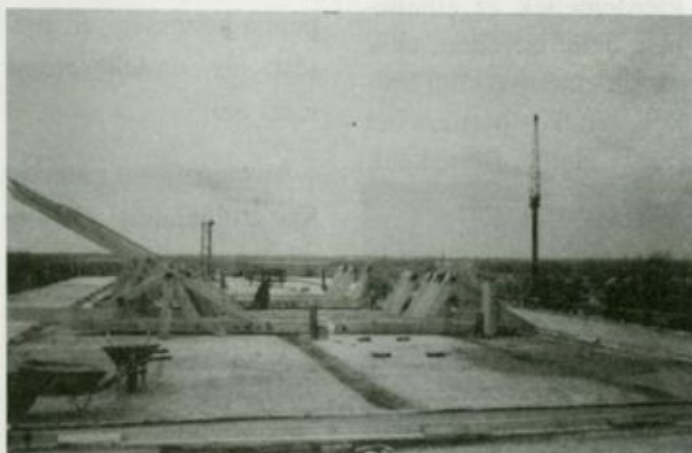
Betonozási munkálatok a tetőszerkezet megépítése előtt
