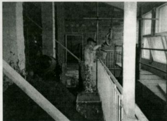
Jó ütemben halad a szakrendelői épület belső tereinek rekonstrukciója
