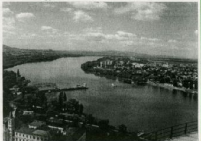
Kollegáink megnézték az Esztergomot Párkánnyal összekötő híd építését is
