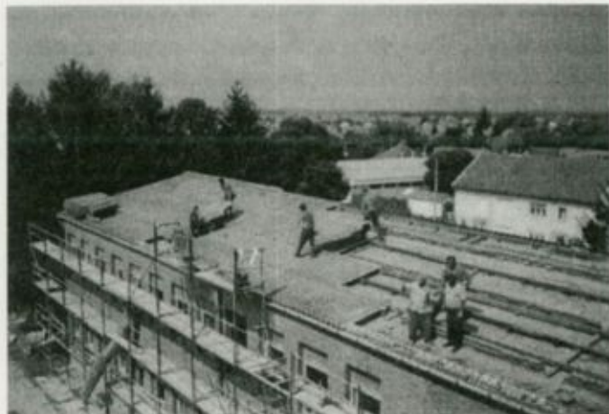
Megkezdődött a szakrendelői épületszárny tetőszerkezetének cseréje
