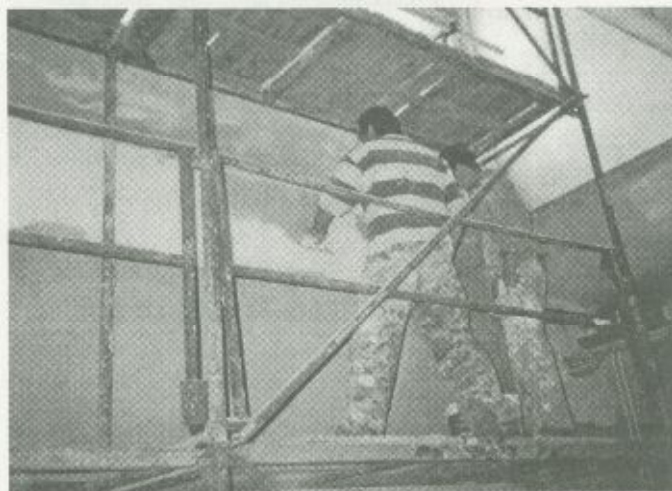
Utolsó simítások a szakrendelői épület egyik belső falán
