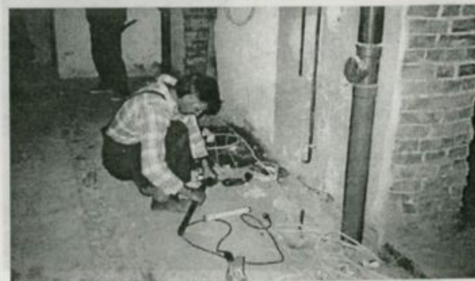
Vízvezeték szerelési munkálatok az alagsorban
