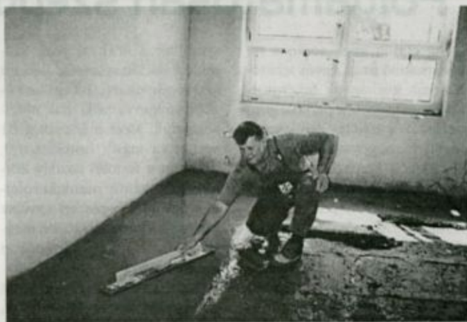
Aljzatbeton készítése a 2. emeleten
