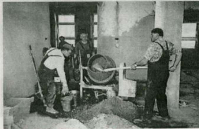
A Kelet/Építő Kft. dolgozói folyamatosan készítik a falazáshoz, aljzatbeton-készítéshez és vakoláshoz szükséges kötőanyagokat
