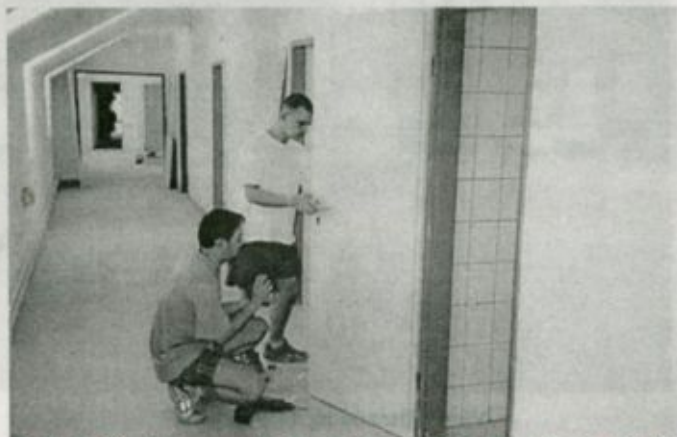
Felvételünkön a kivitelező cég szakemberei a tetőtér nyílászáróinak beszerelésekor láthatók
