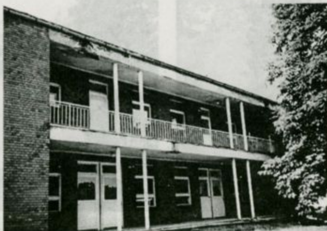
Remélhetően hamarosan megkezdődhet a fertőző osztály épületének rekonstrukciója is
