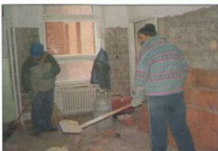
Zavartalanul folyik a munka bent...
