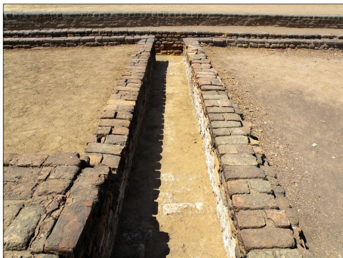
Téglával bélelt csatornahálózat részlete Lóthalban, az Indus-völgyi civilizáció kikötővárosában, Kr. e. 2900. A mellékcsatornák derékszögben csatlakoztak be az 1,9 m mély főcsatornába. Az egyes ágakba 2-3 lépcsőt építettek be, hogy megakadályozzák a szilárd szennyezés továbbhaladását, így csak a folyékony szennyvíz jutott be a közeli folyóba, majd a tengerbe. Fotó: Raveesh Vyas 2009. (Wikimedia Commons CC2.0)
